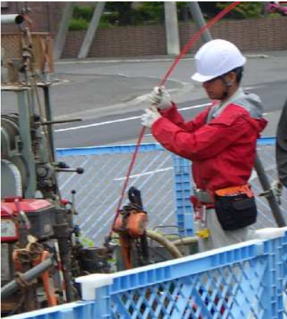
水圧アンカー及びロッド挿入
