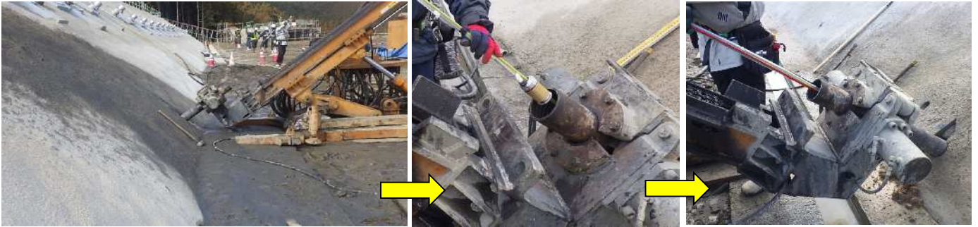
ロータリーパーカッション削孔
