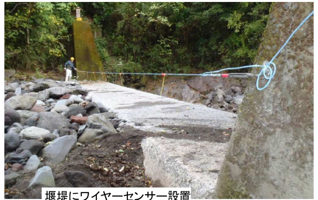
堰堤にワイヤーセンサー設置
